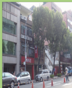
都更透天店 57坪 民生東路2段 大馬路旁 2層另增建 土地38坪 收租中
